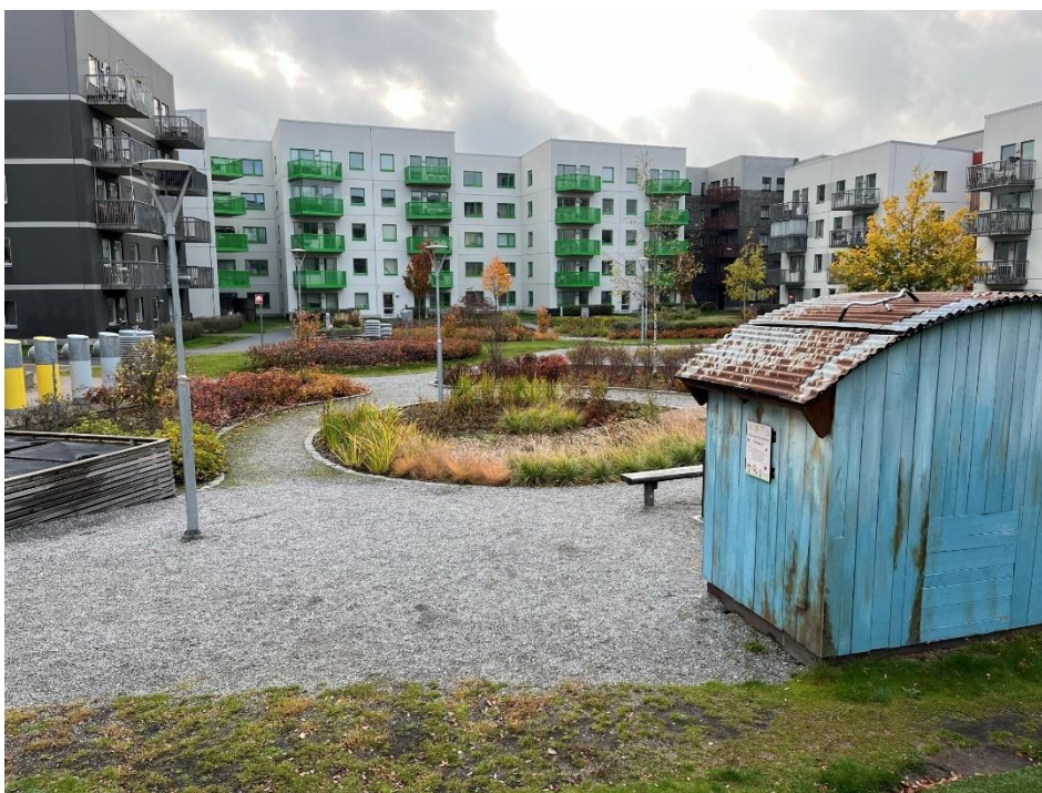
Figur 4-2 Exempel på höjdsättning och utformning av innergård med hänsyn till dagvatten och skyfallshantering. Järfälla, Stockholm. Foto: DHI.
